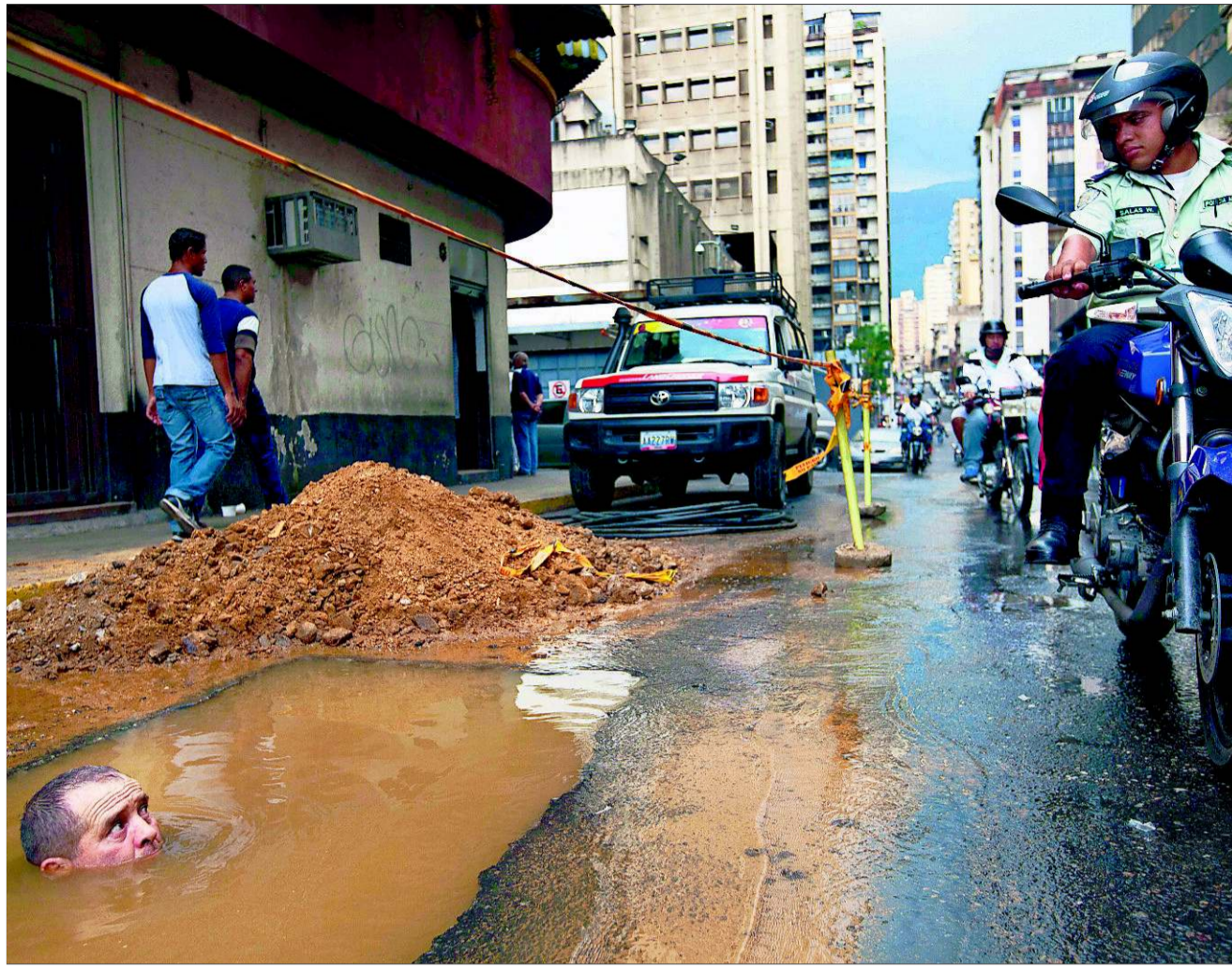
Was sagt oder fragt der Blick des Arbeiters in der Grube?
